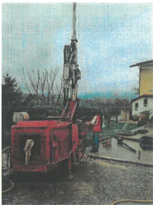
Sondaggio S1-2023 Via N. Bixio
