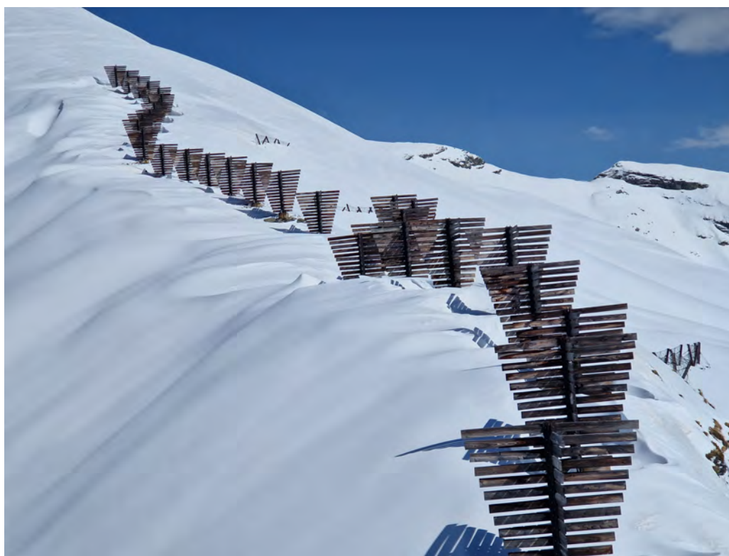
Figura 4.5 – Frangivalenti a croce (o ad albero rovesciato) posti nella zona di cresta del bacino valanghivo di Lavanchers in Morgex, Valle d’Aosta (Segor, 2024).
